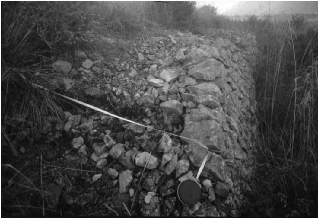
Fig. 2 Muretto di sostegno di un terrazzo (spessore 2 metri circa), parzialmente smantellato per meglio evidenziarne la struttura. Cross section of an abandoned terrace stone wall (about 2 meters wide); note the difference in stone size and structure between the internal and external parts of the wall.
